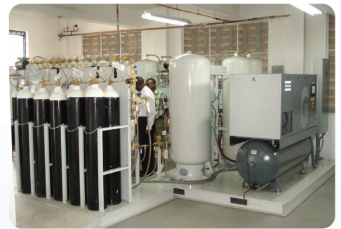
Planta dúplex de oxígeno PSA para uso medicinal AS-J450-HMFM - Kenia
