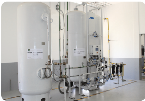
Planta dúplex de oxígeno PSA para uso medicinal AS-Q2600-HM - Nicaragua
