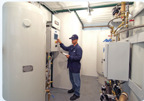
Planta de oxígeno PSA prefabricada de alta pureza en contenedor AS-J250-HPCR para las Fuerzas de la OTAN - Afganistán
